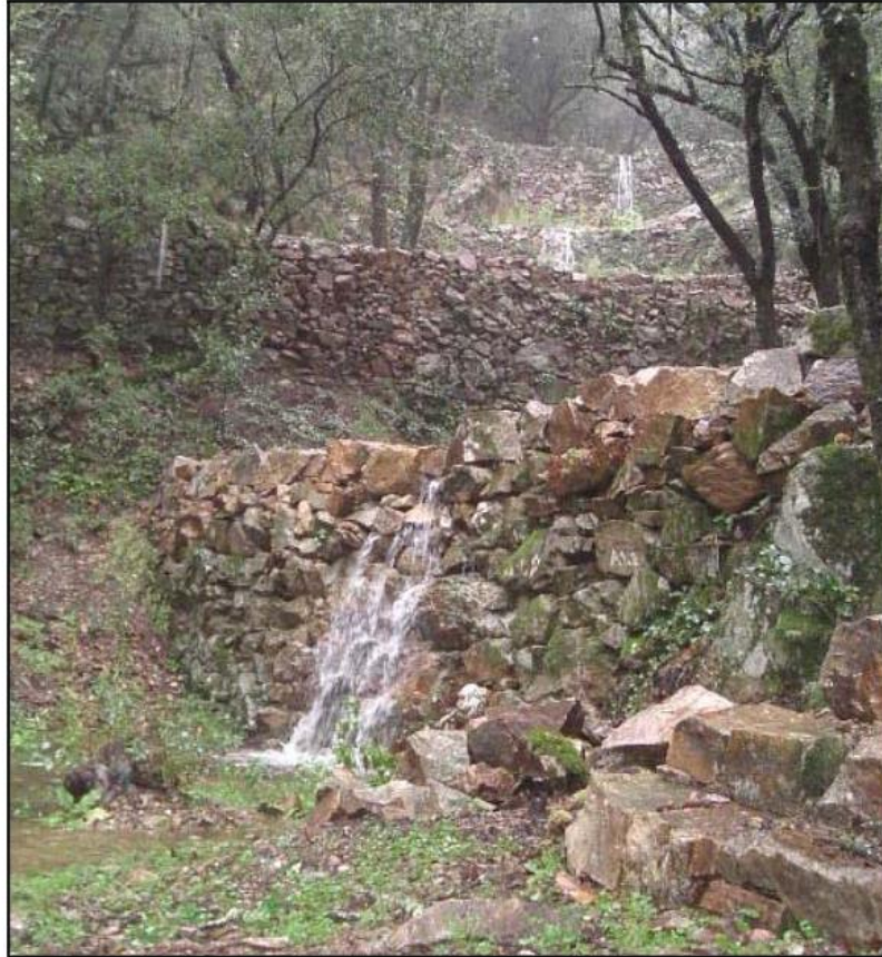
Photo 5 - Tancats (réhabilités), en continuité avec des terrasses, sur un affluent en pente forte du valat des Abrits. (cliché : J.F. DIDON-LESCOT)
